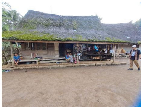
Gambar 6: Dokumentasi atap rumah adat Kampung Naga terbuat dari anyaman daun nipah atau ijuk Sumber: Dokumentasi Ranuhandoko, 2023
